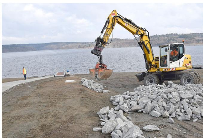
Noch ausstehende Arbeiten sind die Kennzeichnung von Gefahrenstellen sowie die Installation der Antriebs- sowie Bedieneinheit des Schwimmsteges und der entsprechenden Einhausung. Neben der Betonbahn, auf der die Boote per Trailer rückwärts ins Wasser gefahren bzw. gelassen werden können, wurde ein Wendebereich für die Fahrzeuge errichtet. Mit Wasserbausteinen wurde außerdem der Bereich der Böschung zur Slipanlage gesichert, informiert Andreas Freund vom zuständigen
